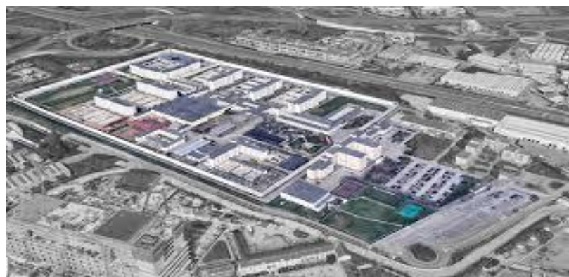
Fig.1 Carcere di Bollate veduta aerea
